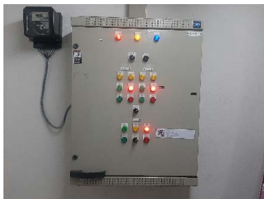
ตู้ควบคุมระบบบำบัดน้ำเสีย และมอเตอร์ไฟฟ้า
