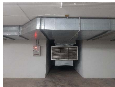
พัดลมระบายอากาศในอาคารจอดรถ
